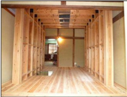
参考 1: j.Pod&耐震工法協会「耐震シェルター」施工例
