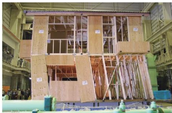
構造用合板が外れて性能を失った (外観を平面図右側から見た様子)
